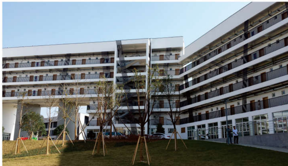
» 悉奥涂料——浙江科技学院安吉校区中德工程师学院
