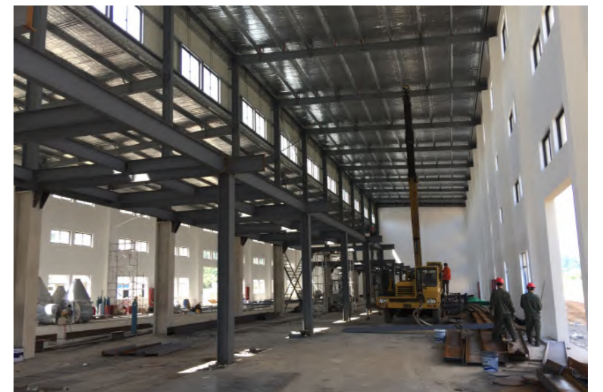
» 高虹新厂房主车间正紧锣密鼓施工中
