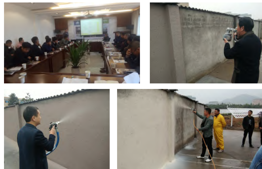
» 项目班组试用机械化喷涂设备
