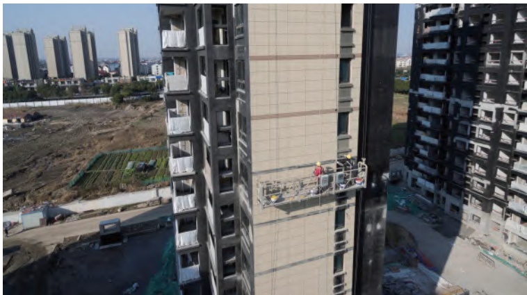
» 施工工人正在高空作业
