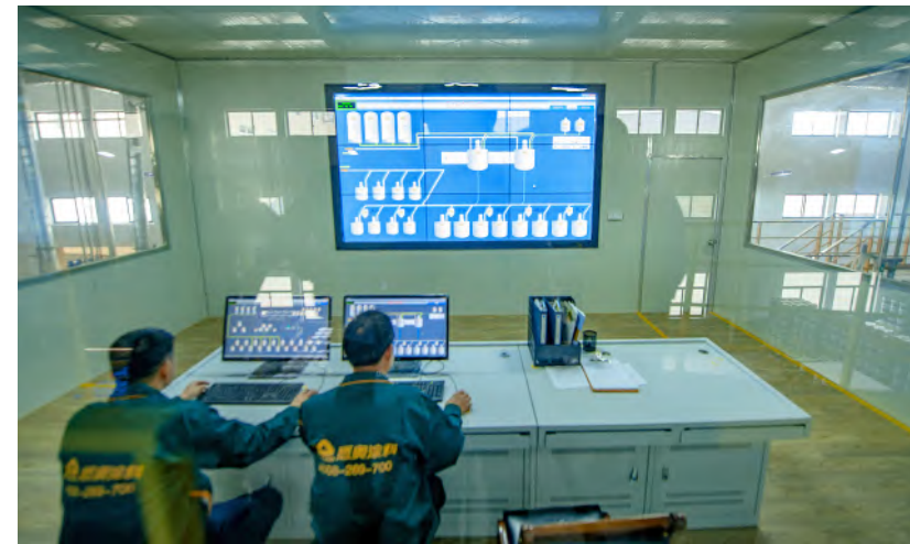
» 悉奥水性涂料工厂中控室
