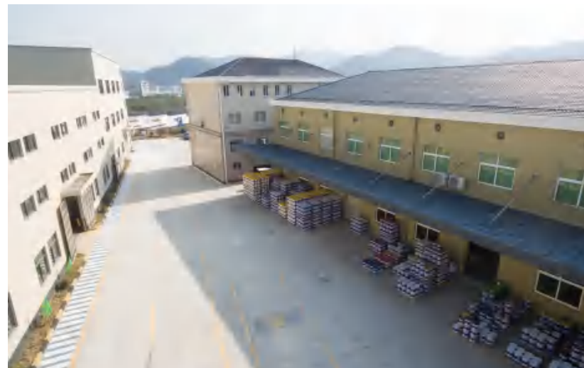
» 生产车间装卸区
