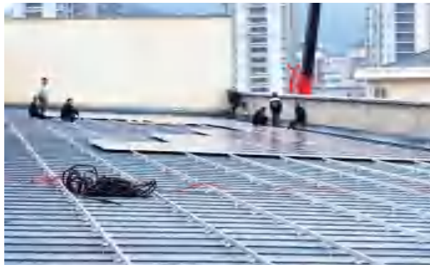
» 光伏安装现场
