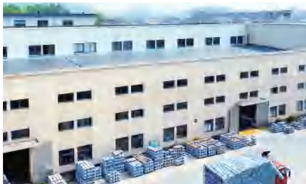
» 光伏安装完成
