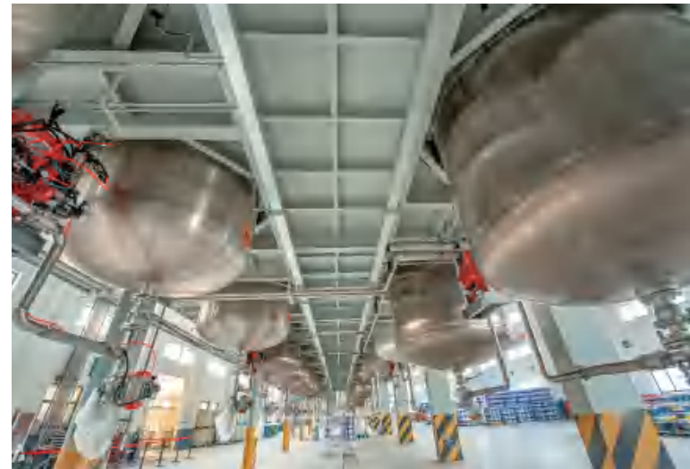
» 悉奥水性涂料生产车间
