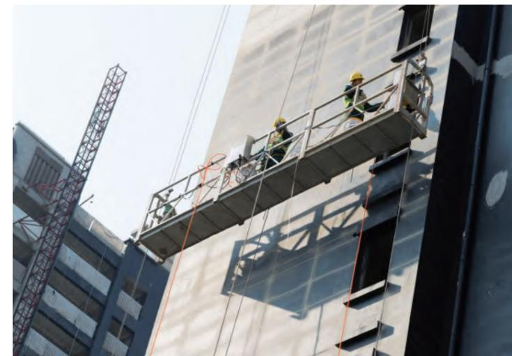
间，腻子不宜厚批，而且一定要等到腻子完全干燥后才可以进行打磨，这样才能做到不粘砂纸，表面平整度也容易被控制。
