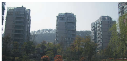
临江西雅园外墙涂料工程
